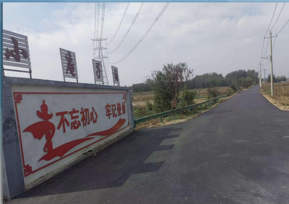
徐家河村路面硬化提升
